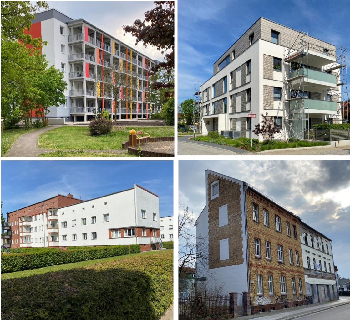
Abbildung 17 Umbau, Neubau und Sanierung in Finsterwalde Quelle: eigene Fotos
